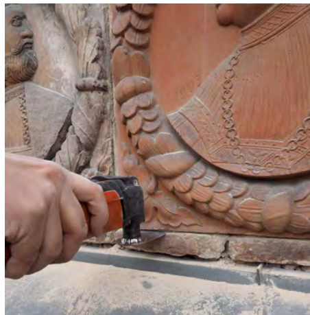
Abb. 12/13 Entfernung der Verfugung mittels Knüpfel und Eisen (links) und mittels Fugenschneider (mittig), 2018 (Fotos: RaO).
