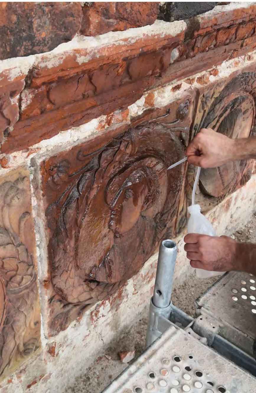
Abb. 15 Festigung durch Fluten, 2022 (Foto: Krekeler Architekten Generalplaner GmbH).
