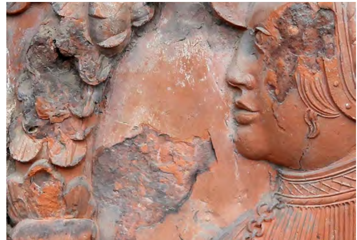
Abb. 9/10 Terrakotte mit fest aufliegenden Verschwärzungen (links) und mit bereits abgestoßenen Krusten (rechts), 2018 (Fotos: Matthias Zahn).
