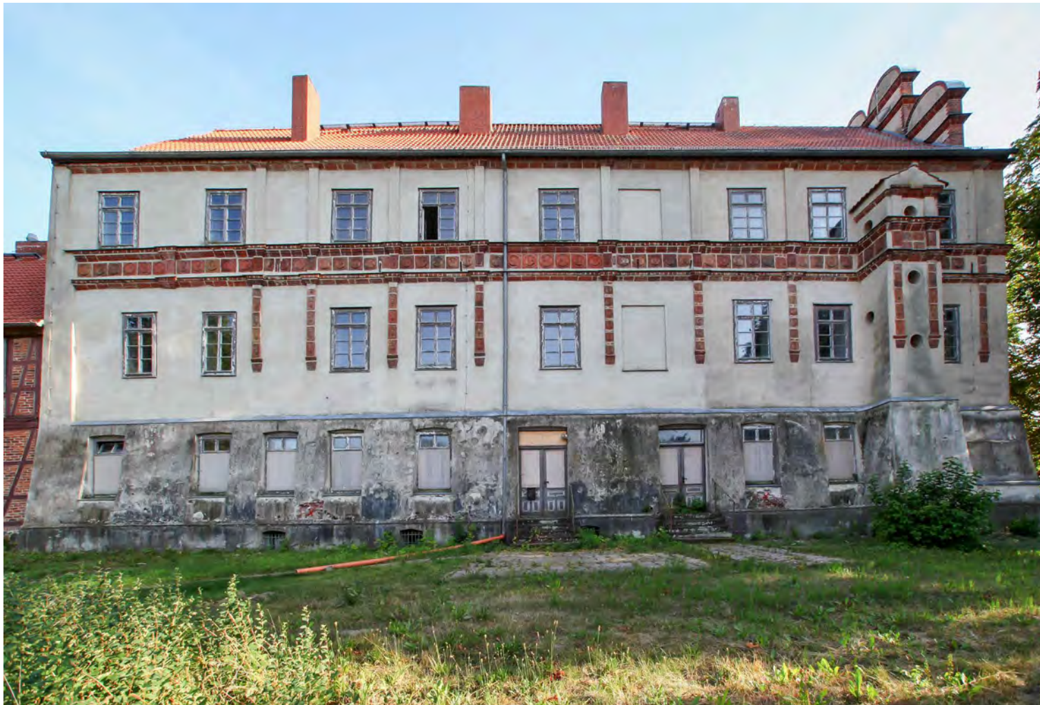
Abb. 1 Nordfassade vor der Sanierung, 2018 (Foto: Matthias Zahn).
