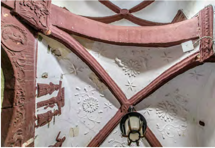
Abb. 9 Gewölbe im Treppenraum, 2018 (Foto: Matthias Zahn).
