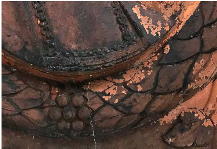
Abb. 9/10 Terrakotte mit fest aufliegenden Verschwärzungen (links) und mit bereits abgestoßenen Krusten (rechts), 2018 (Fotos: Matthias Zahn).
