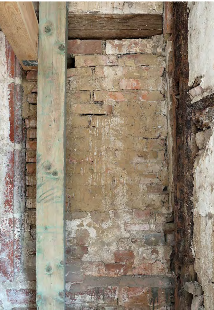
Abb. 7 Zugemauertes Renaissancefenster im Erdgeschoss der Hoffassade (Foto: Matthias Zahn).
