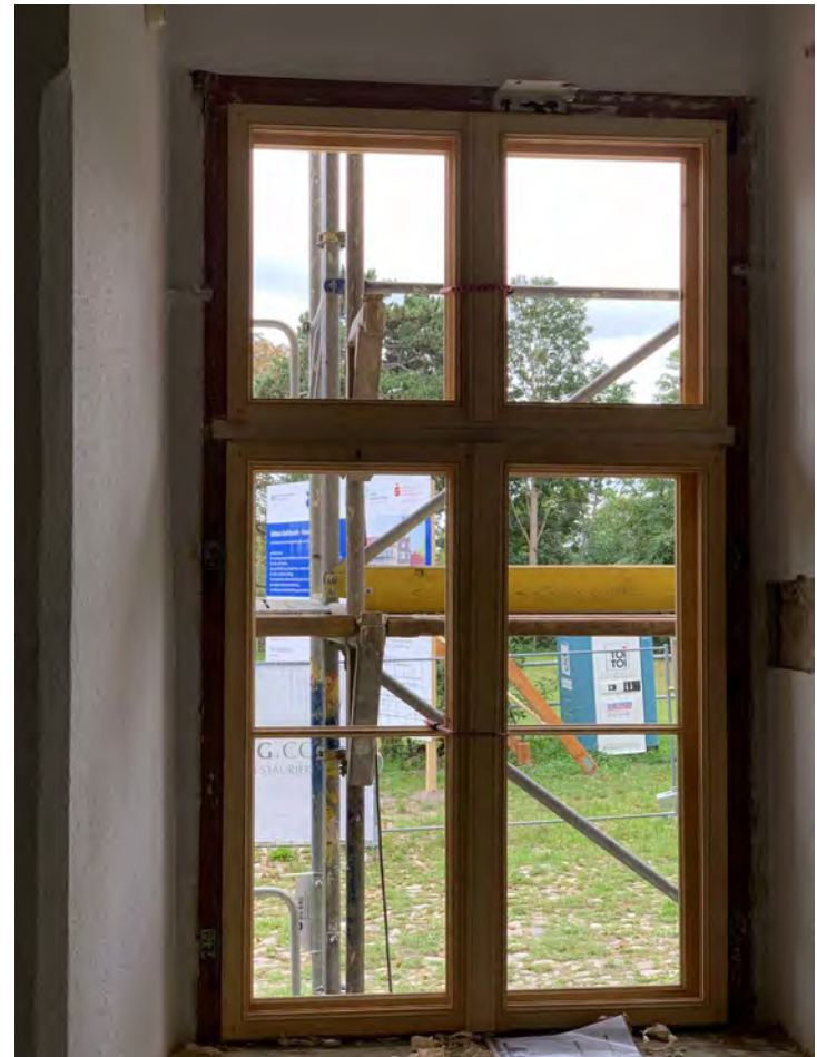
Abb. 7 Wiederhergestellte Kastenfenster der Südfassade, 2021 (Foto: LAKD M-V/LD, Sabine Schöfbeck).
