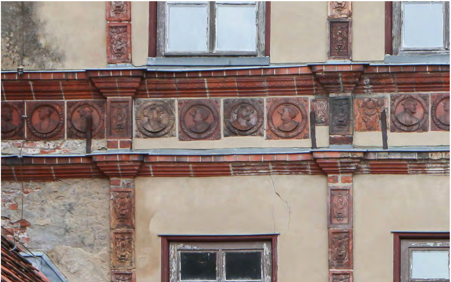
Abb. 4 Südfassade, Medaillons mit uneinheitlichen Formaten, 2019 (Foto: Krekeler Architekten Generalplaner GmbH).
