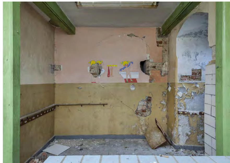
Abb. 5/6 Relikte der Nutzung als Kindergarten bzw. Schulhort im Westteil des Erdgeschosses; Zustand am 30. November 2017 (Foto: LAKD M-V/AD Fotosammlung, Achim Bötefür).
