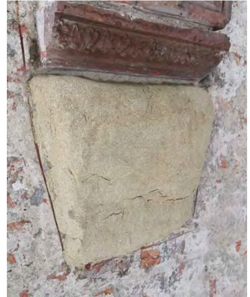
Abb. 19/20 Terrakotte mit Glasfaserarmierung (links) und mit Kittung nach der Restaurierung (rechts), 2018 (Fotos: RaO).
