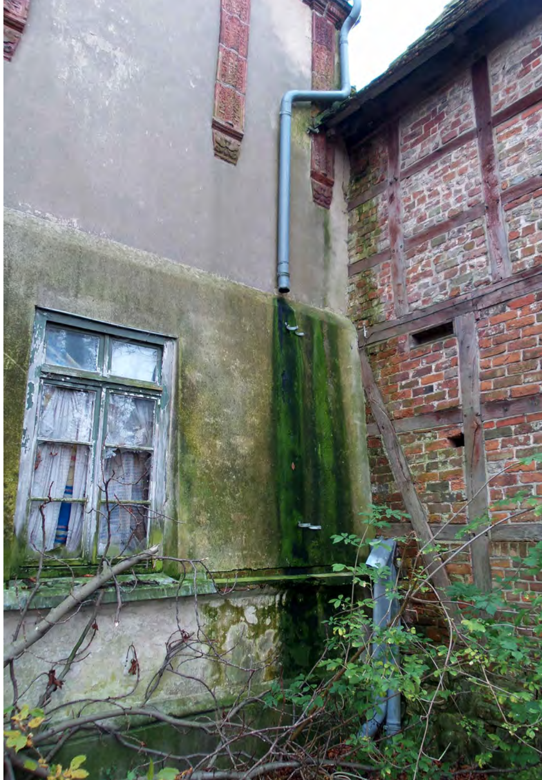
Abb. 9 Feuchtigkeit in der Nordwand des Schlosses, fehlende Türverglasung, defekte Fenster, November 2014 (Foto: Hans-Christoph Struck).
