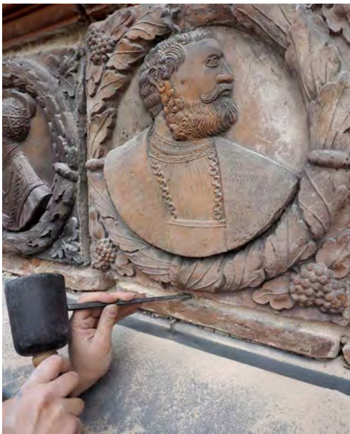
Abb. 12/13 Entfernung der Verfugung mittels Knüpfel und Eisen (links) und mittels Fugenschneider (mittig), 2018 (Fotos: RaO).
