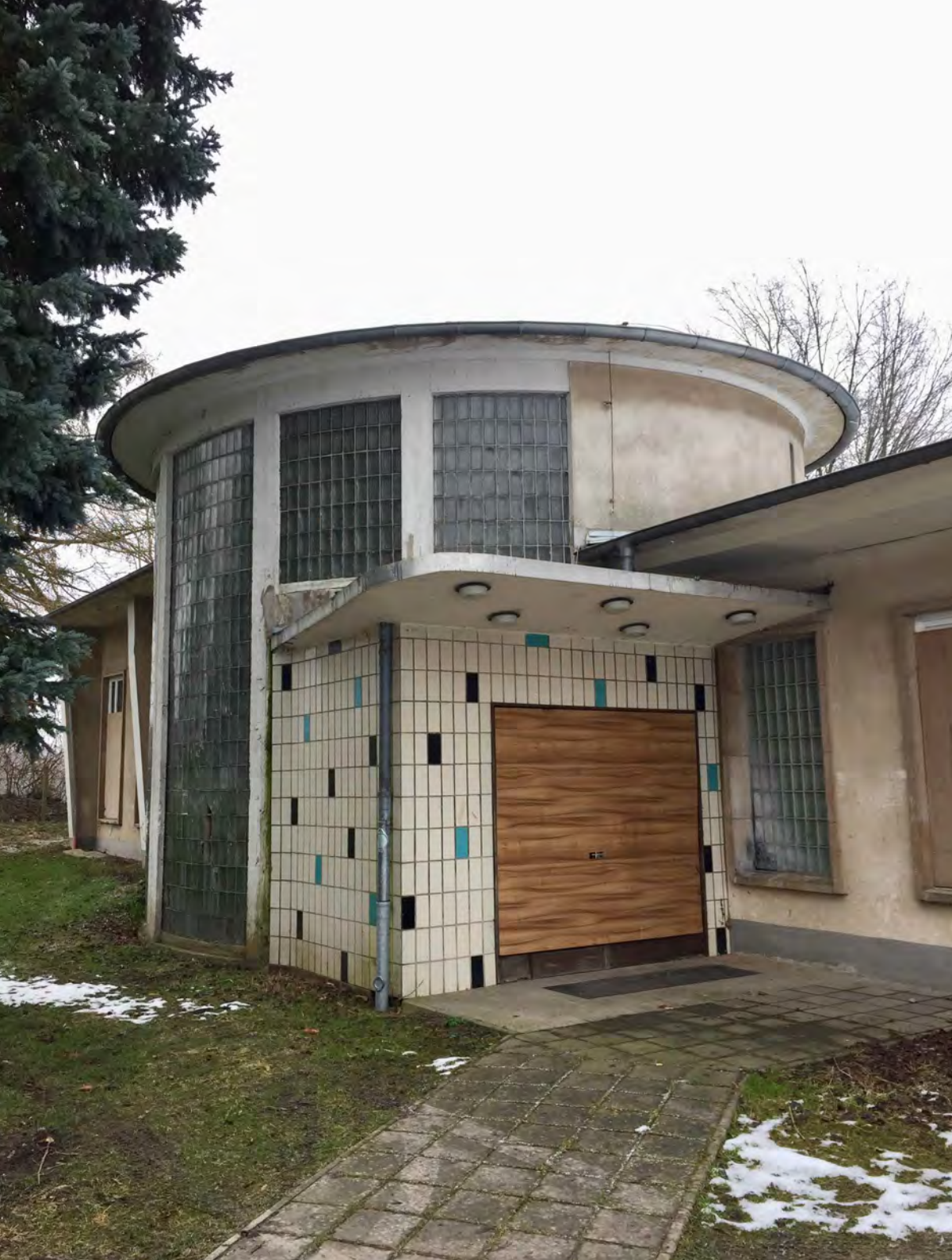
Abb. 10 Eingangsbereich des Schülgängzungsbaus, 2018 (Foto: LAKD M-V/LD, Sabine Schöfbeck).
