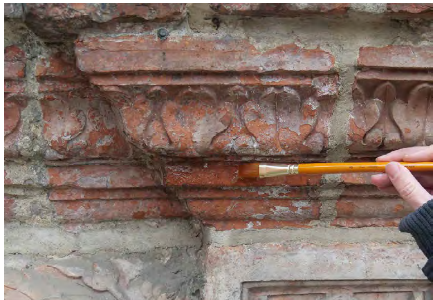
Abb. 15 Festigung durch Fluten, 2022 (Foto: Krekeler Architekten Generalplaner GmbH).
