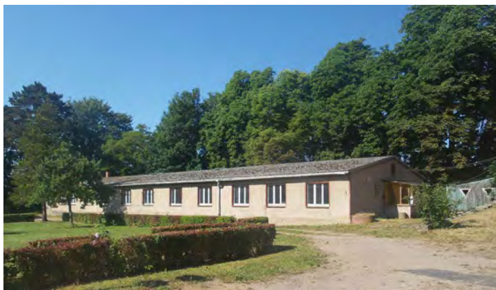
Abb. 3 Steinbaracke, kurz vor dem Abriss, 2015 (Foto: Hans-Christoph Struck).
