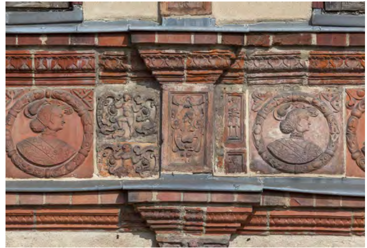
Abb. 12 Hoffassade, Terrakottafries über dem Erdgeschoss, Einbau verschiedenster Terrakotten aus der Renaissance und von 1903 (Foto: LAKD M-V/LD Fotosammlung, Achim Bötiefür).
