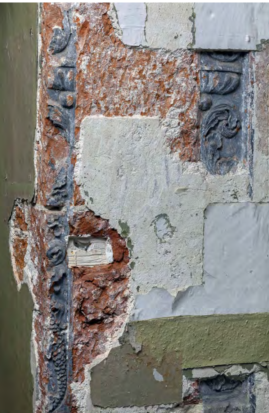
Abb. 14 Abgeschlagenes Terrakottaportal im 1. Obergeschoss des Treppenhauses mit ursprünglicher grauer Fassung (Foto: LAKD M-V/LD Fotosammlung, Achim Bötterfür).
