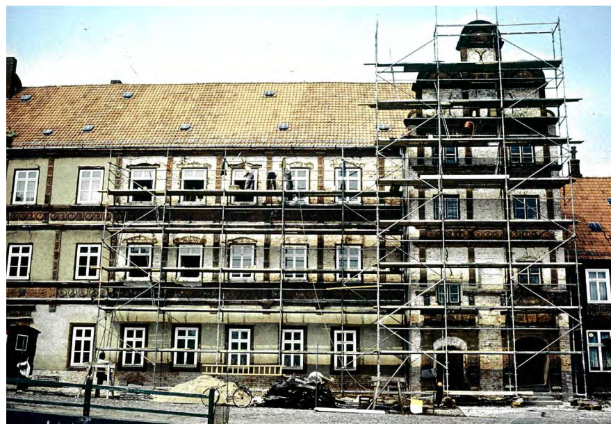
Abb. 3 Sanierung der Südfassade 1988 durch die »Feierabendbrigade Schulz« (Sammlung Schumann).
