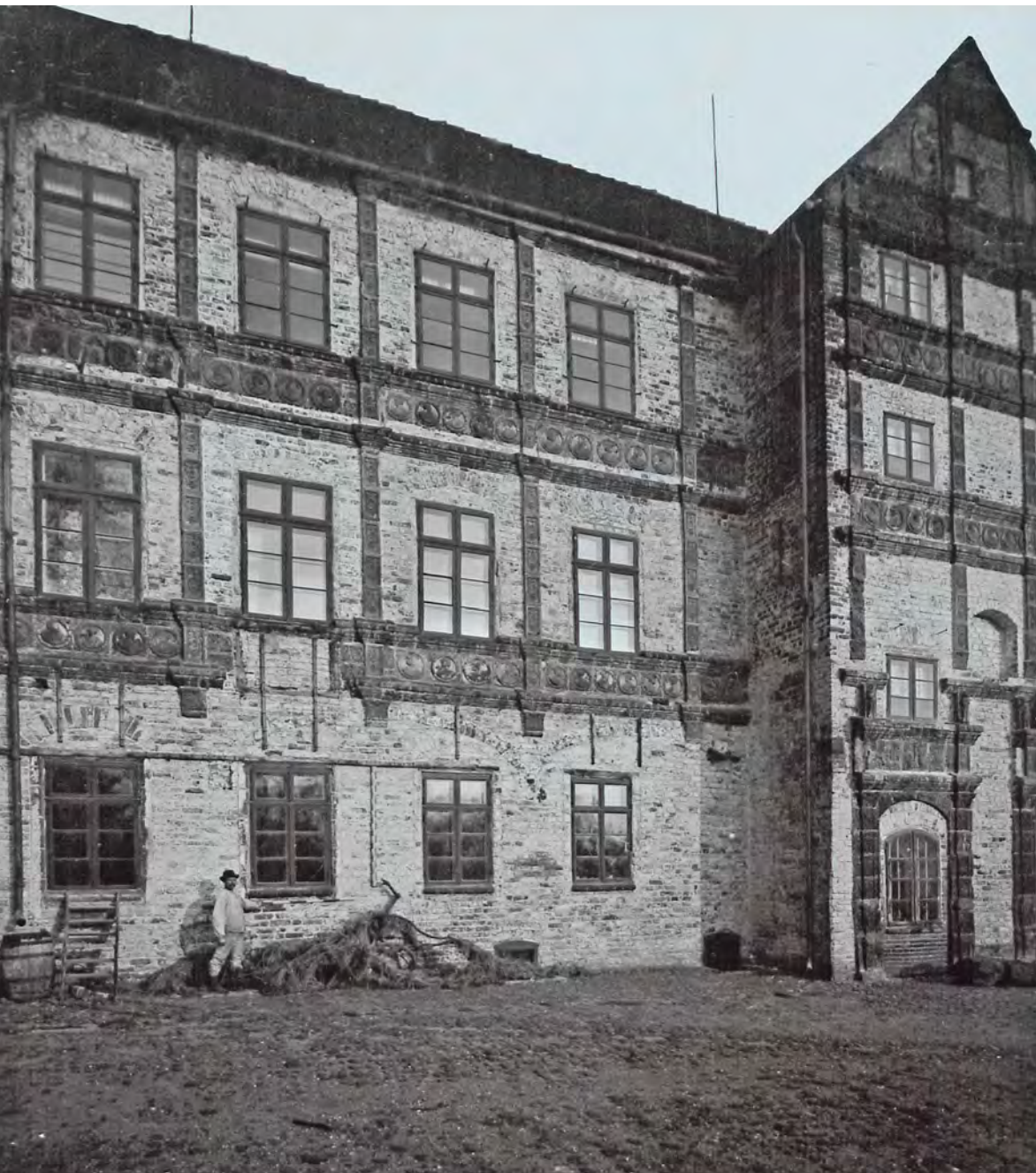
Abb. 4 Südfassade nach Abnahme des Außenputzes, 1903 (LAKD M-V/LHA).
