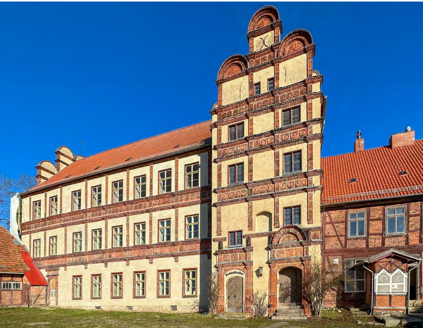
Abb. 9 Südfassade nach Sanierung, 2023 (Foto: LAKD M-V/LD, Sabine Schöffbeck).
