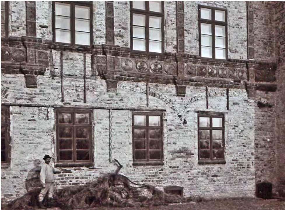
Abb. 5 Hoffassade des Schlosses, 1903, Ausschnitt, im Terrakottafries über dem Erdgeschoss ist eine ehemalige Türöffnung zu erkennen und über den Fenstern sind deutlich flache Gewölbeansätze aus dem Barock zu sehen (LAKD M-V/LHA).
