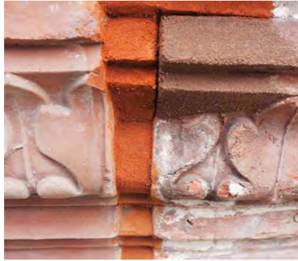
Abb. 19/20 Terrakotte mit Glasfaserarmierung (links) und mit Kittung nach der Restaurierung (rechts), 2018 (Fotos: RaO).
