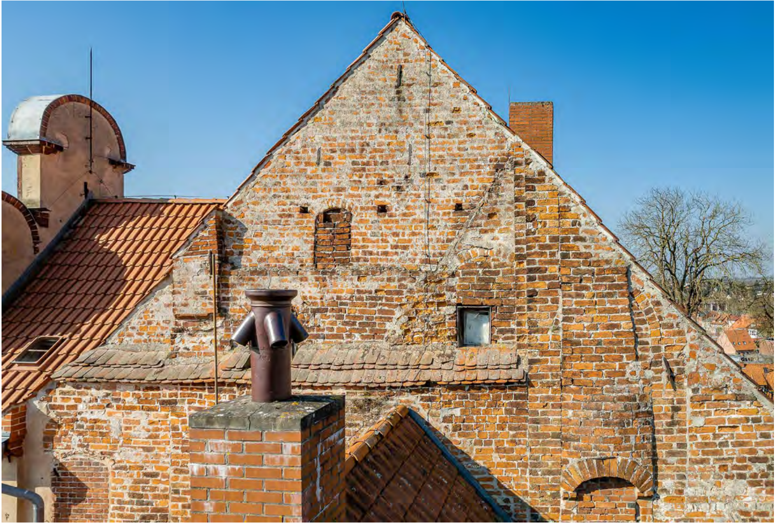
Abb. 1 In Teilen noch mittelalterlicher Ostgiebel des Schlosses mit angebaute jüngerer Kaminhaube (Foto: Tilo Schöbeck).
